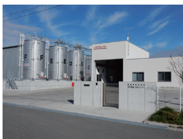
神戸製造・分析センター Kobe Technical Center
